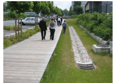
Noue de stockage à Clichy-sous-Bois
