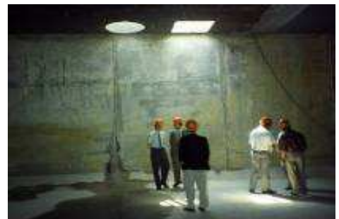
Bassin enterré visitable
